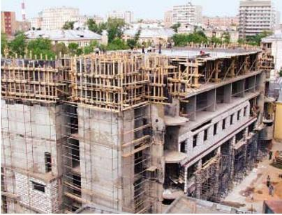
Рис. 1. Строительство методом скользящей опалубки
