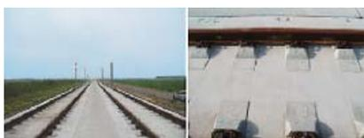
Рис. 8. Железнодорожный путь с забетонированными двухблочными шпалами
