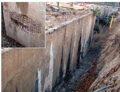
Рис. 6. Разрушение стен железобетонного топливного резервуара
