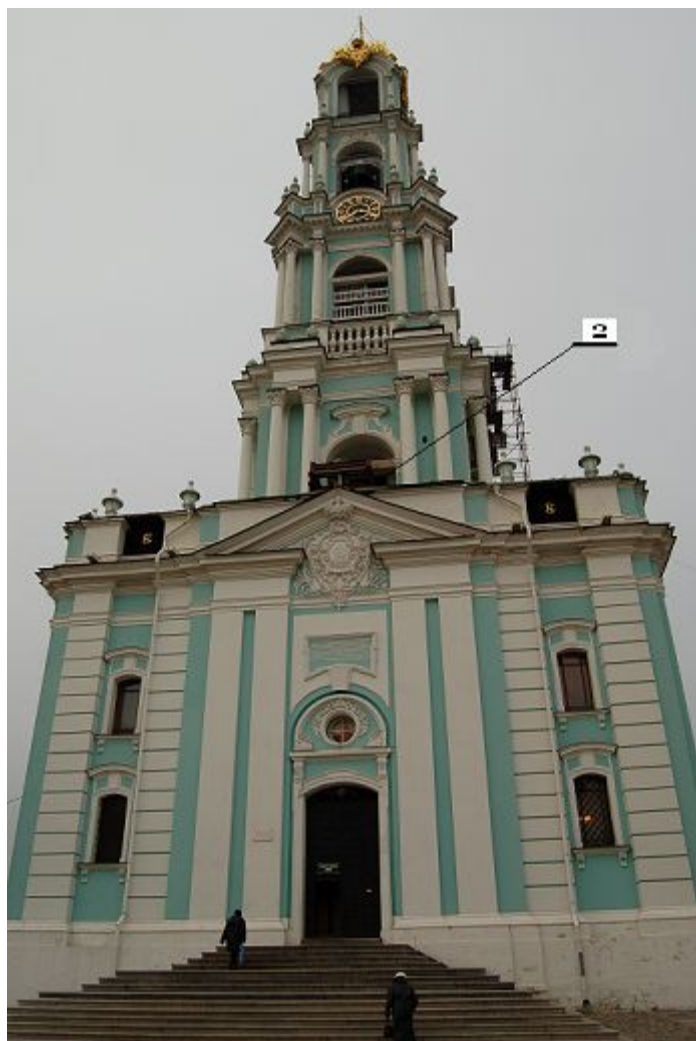
Рис.2. Общий вид колокольни и места колокола.
