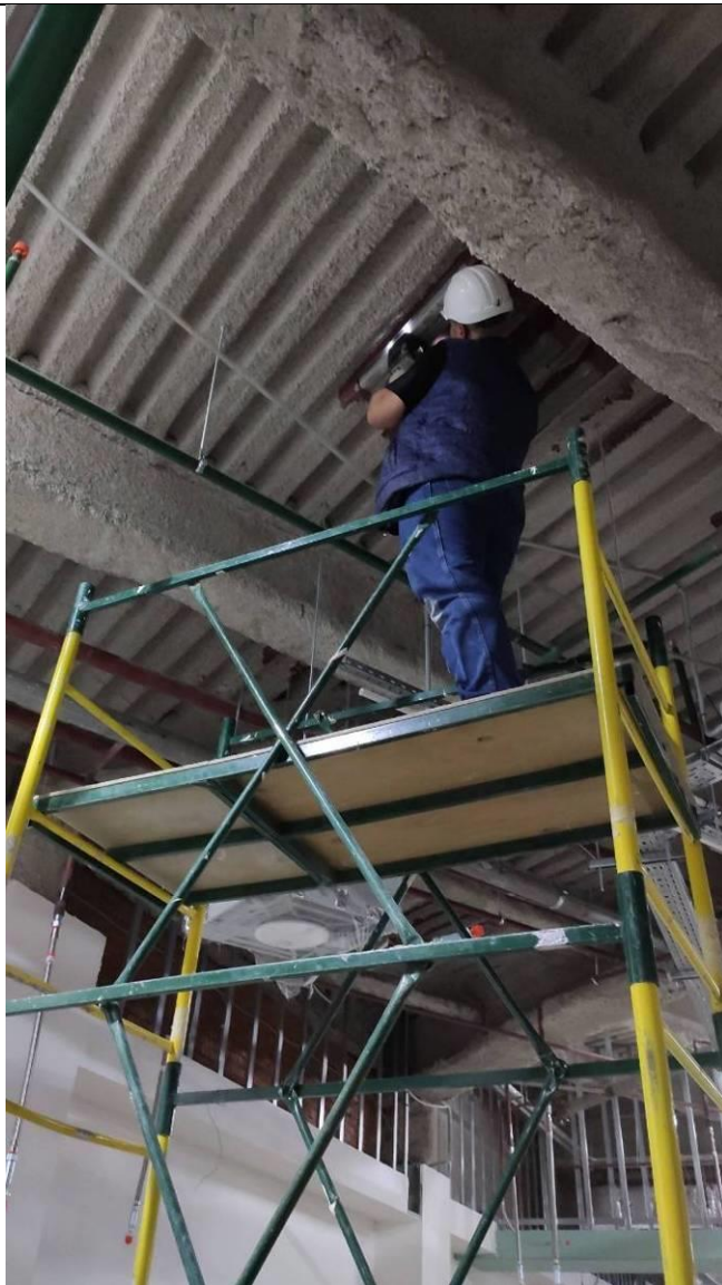
Общее фото контроля потолочного перекрытия
