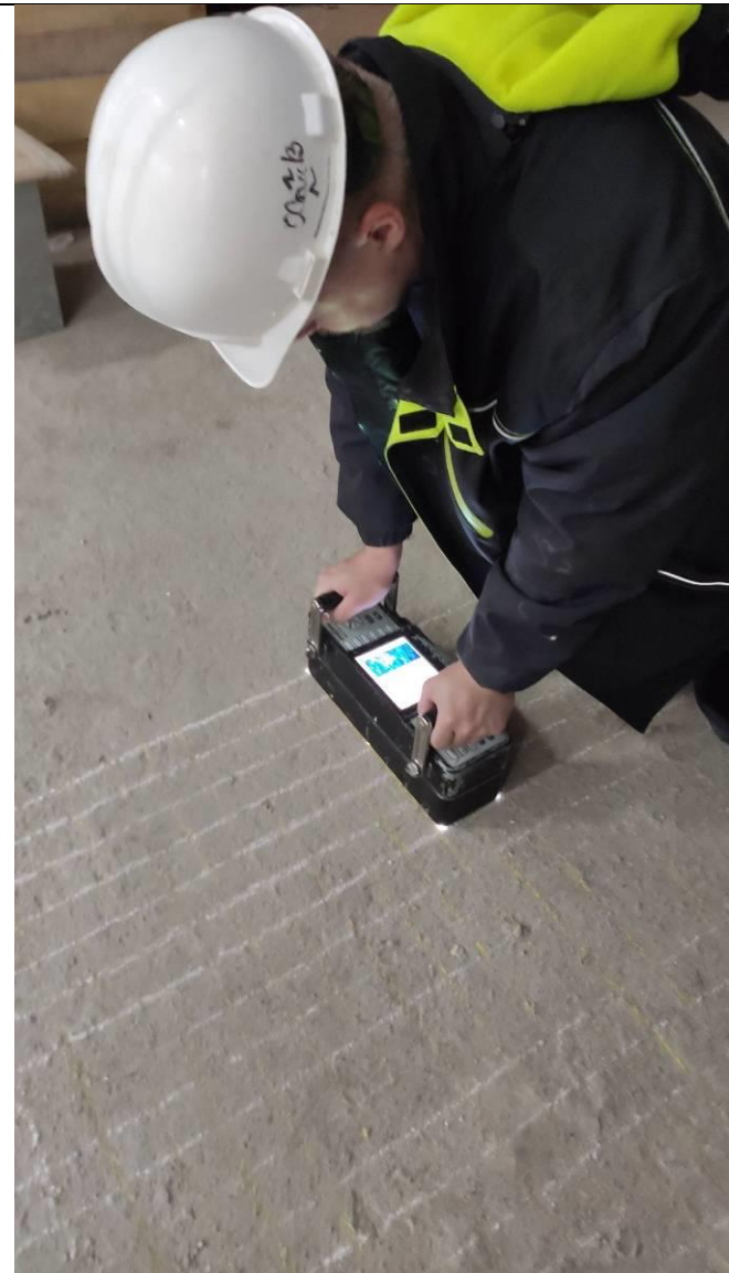
Общее фото контроля полового перекрытия
