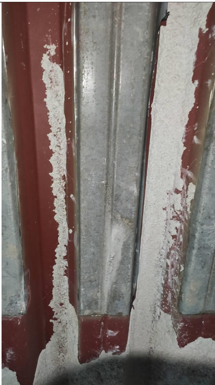
Фото фрагмента вскрытия несъемной опалубки потолочного перекрытия
